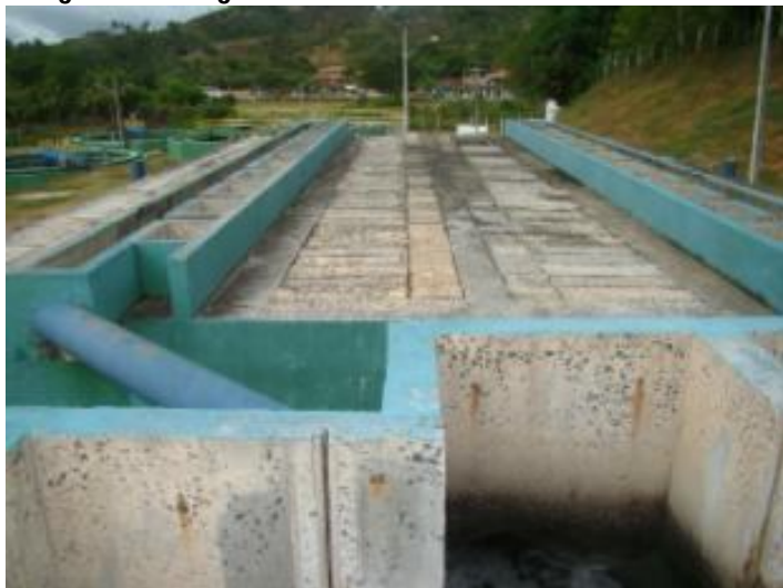
Figura 50 – Fotografia dos Digestores Anaeróbios de Fluxo Ascendente - DAFA's na ETE.
