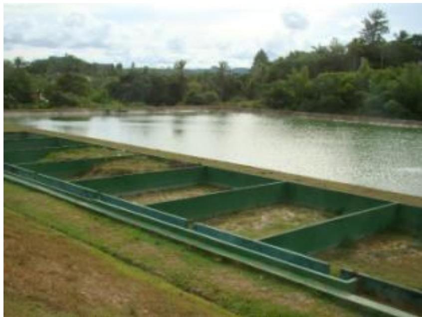
Figura 53 - Fotografia dos leitos de secagem e lagoa de maturação.
