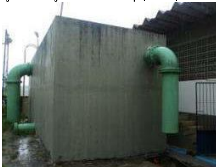
Figura 35 - Fotografia do reservatório/poço de sucção de 75 m 3 .
