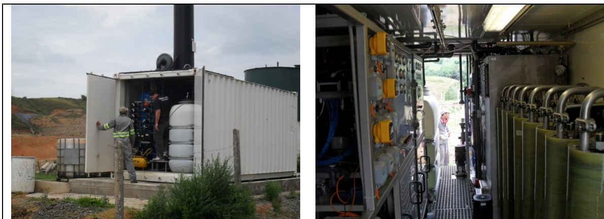
Figura 117 - Fotografias do Sistema de tratamento do lixiviado - Osmose reversa - aterro sanitário CITA BAHIA - São Francisco do Conde
