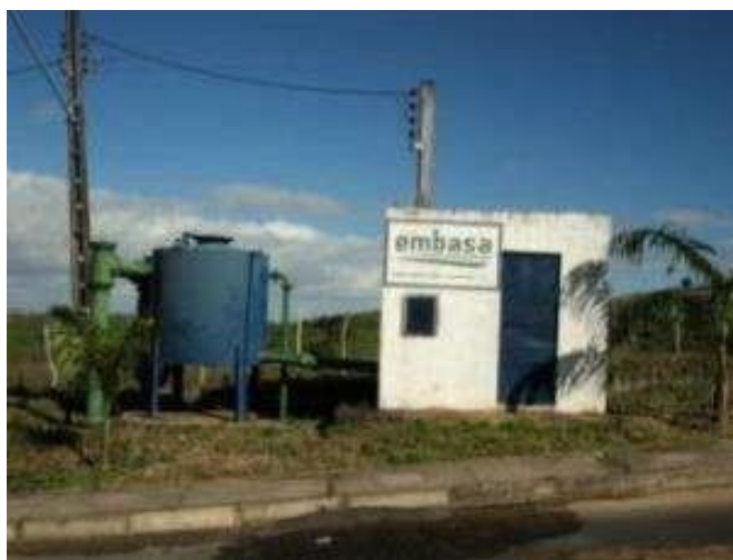
Figura 37 – Fotografia do “booster” da localidade Monte Recôncavo
