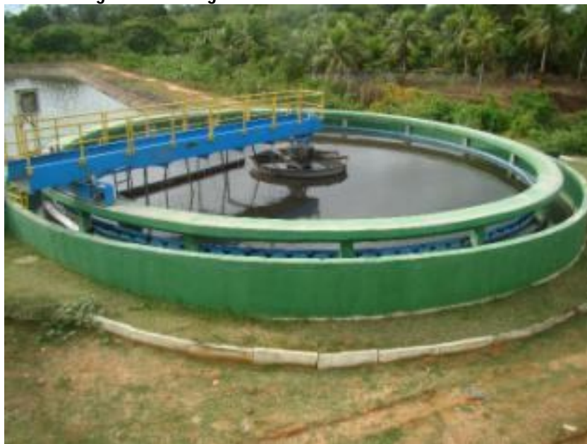
Figura 51 - Fotografia do Decantador localizado na ETE.
