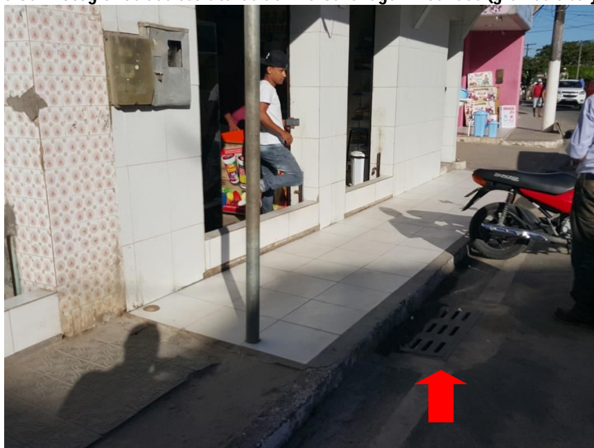
Figura 56 - Fotografias das estruturas de microdrenagem nas ruas (grelhas e sarjetas)
