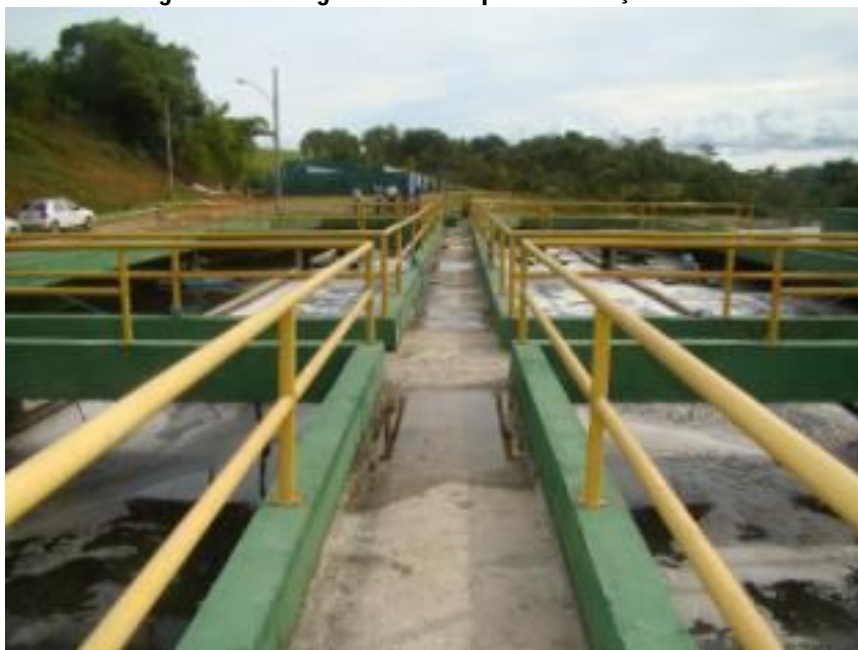
Figura 52 - Fotografia dos tanques de aeração na ETE.
