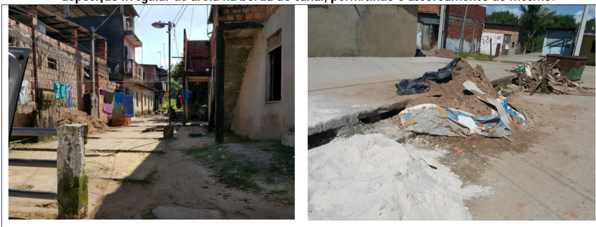
Figura 60 - Fotografias dos canais de drenagem cobertos na Babilônia e em Drena, com destaque para a deposição irregular de areia na borda do canal, permitindo o assoreamento do mesmo.
