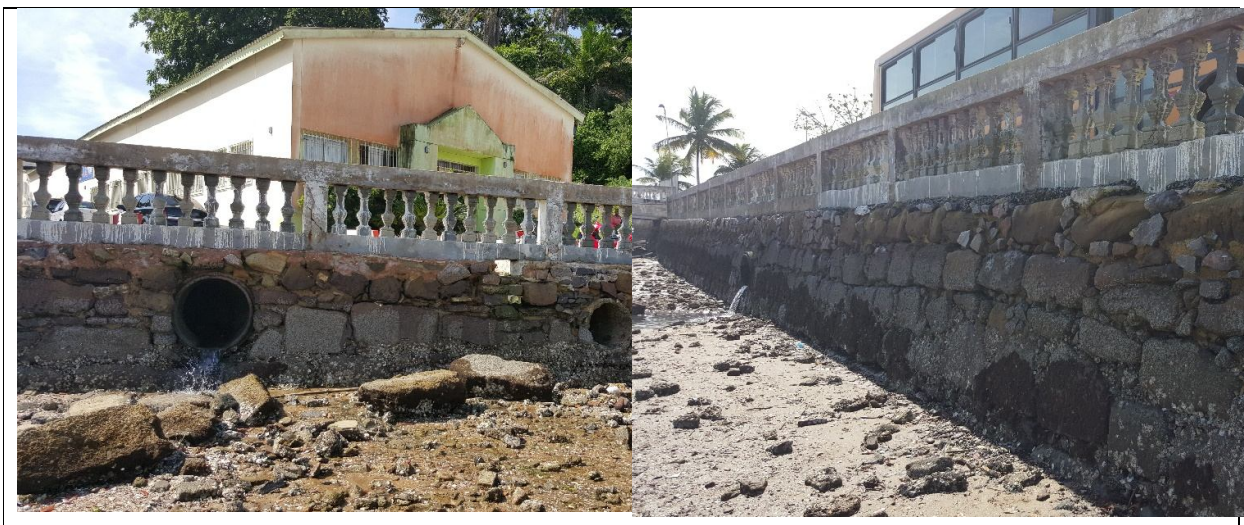
Figura 59 - Fotografia do lançamento de águas pluvias com possíveis contribuições de efluentes no Cais de São Francisco do Conde.
